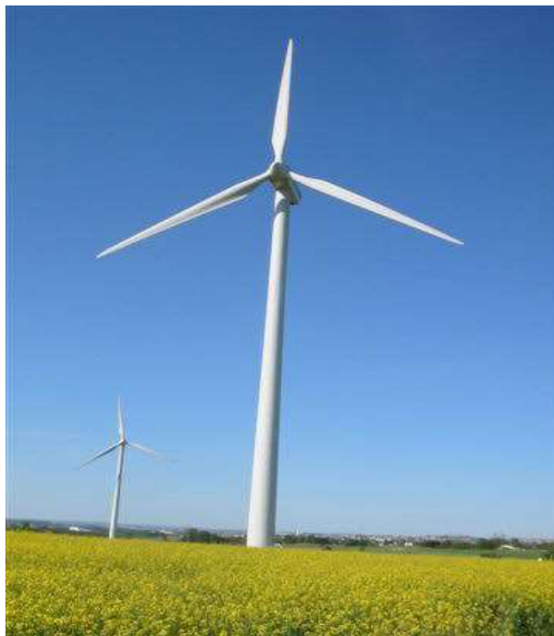
Figure 3.1 : Éolienne à axe horizontale 25
